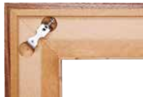
łączenie (od tyłu) listwy pionowej z poziomą
