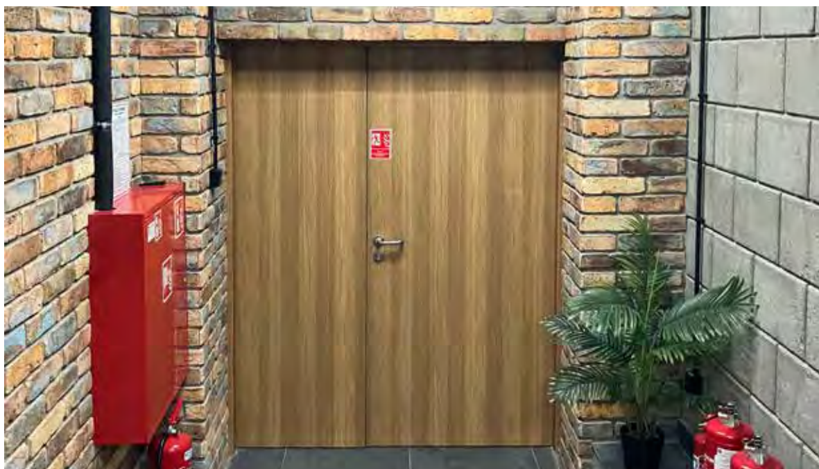
drzwi przeciwpożarowe FR EI30, ościeżnica stała drewniana
