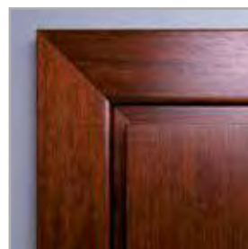
łączenie opasek pod kątem 45°
