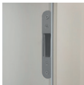
Zaczep zamka magnetycznego
